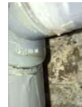
Filtración bajante
