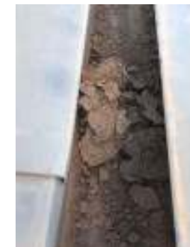
Limpieza de canales
