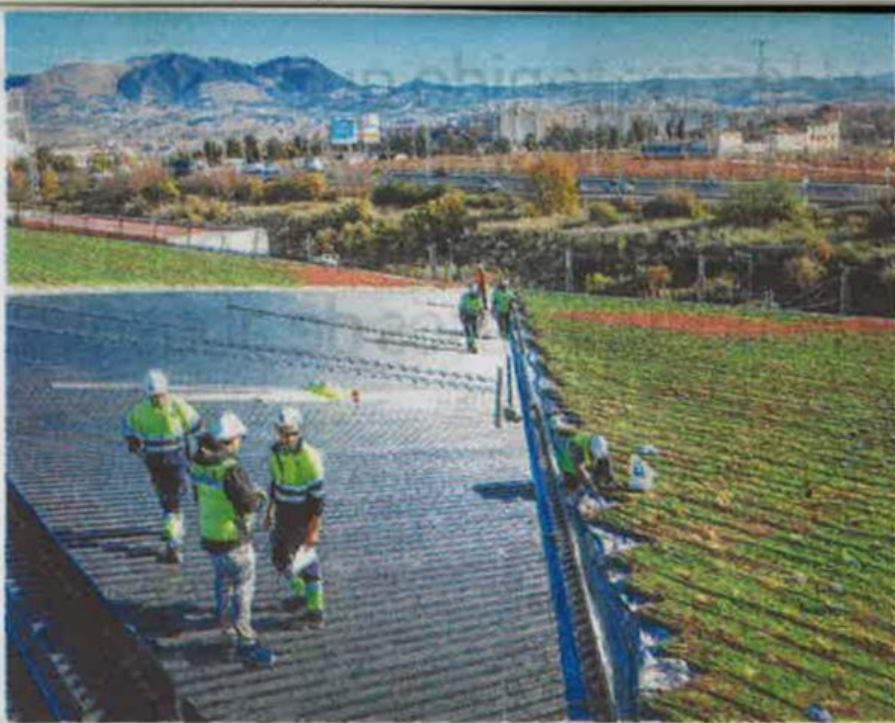
Trabajadores en el tejado de las cocheras del metro. RAMÓN L. PÉREZ
